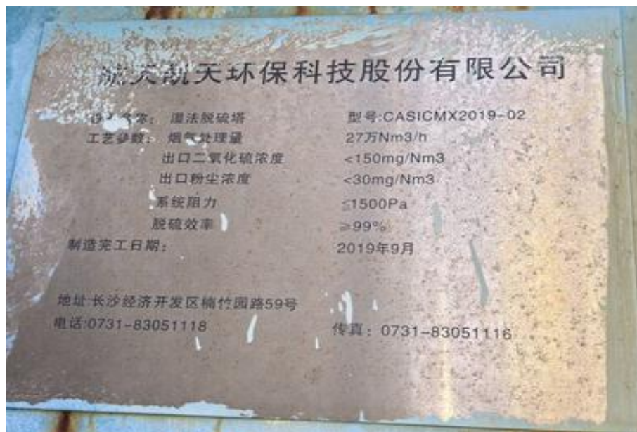
图 1 脱硫塔基本信息铭牌
